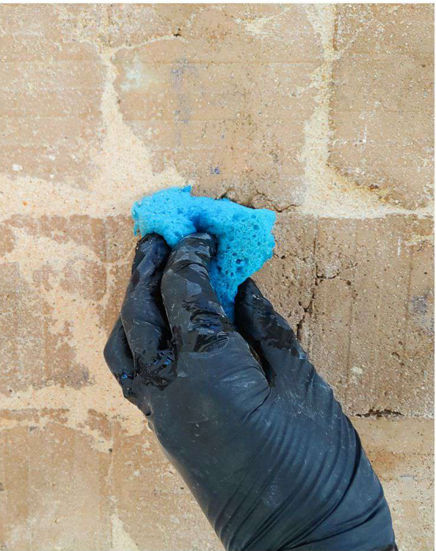
RELLENO DE MORTERO HIDRÁULICO
